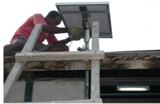
Pekerja Memasang Solar Cell
