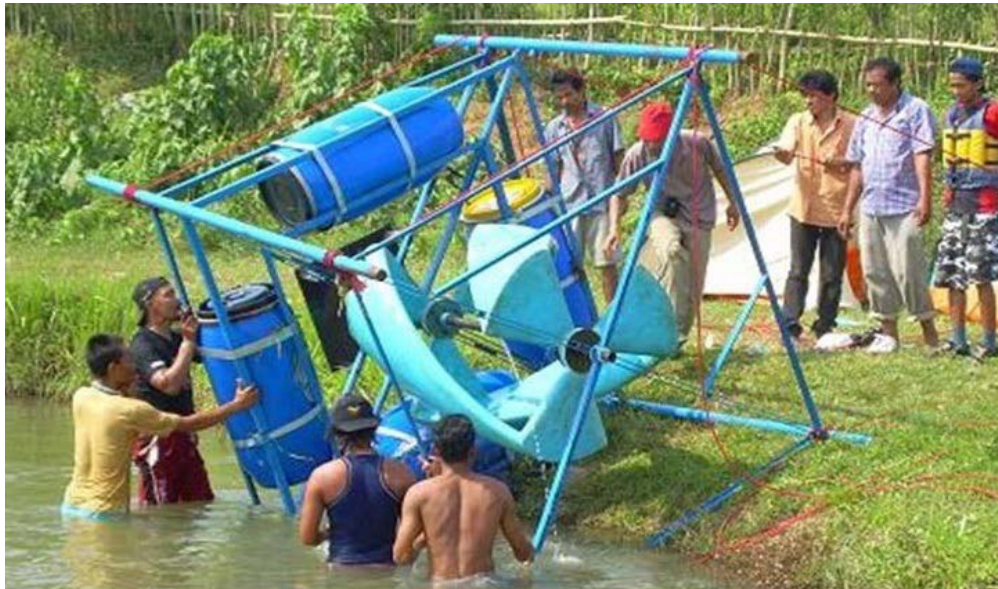
Pemasangan Turbin Arus Laut
