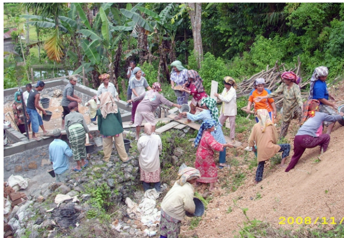
Pekerja perempuan sedang membantu membangun MCK
