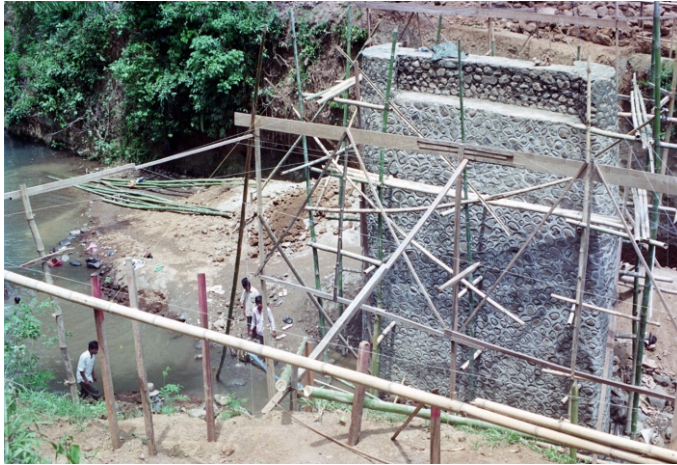
Masyarakat sedang membangun pilar jembatan tinggi di sungai
