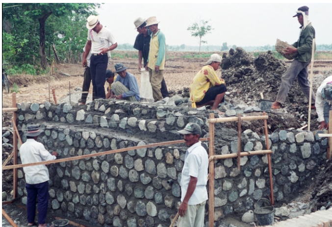
Para pekeraja desa sedang membangun abutmen jembatan
