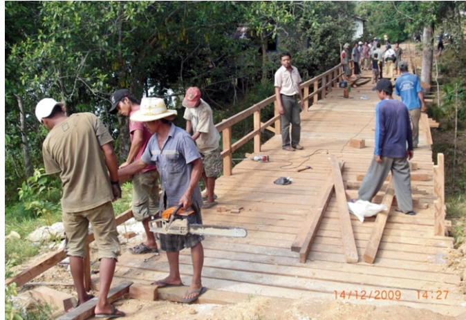
Pekerja desa sedang membangun jembatan kayu yang cukup panjang
