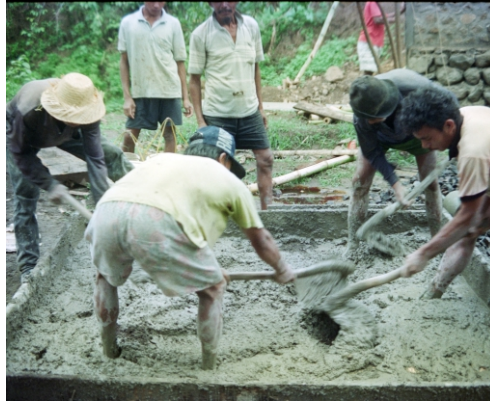
Mencampur Beton secara Manual
