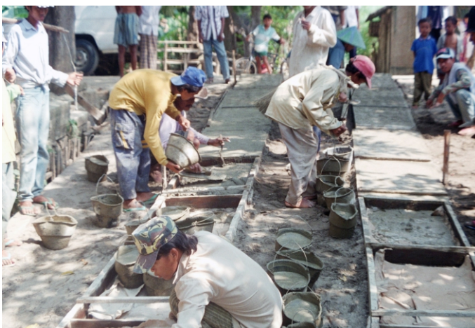
Pekerja sedang membuat balok untuk jalan beton
