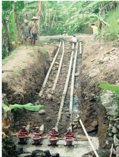
Pemasangan empat pompa hidram dengan pipa galvanis Ø 3"
