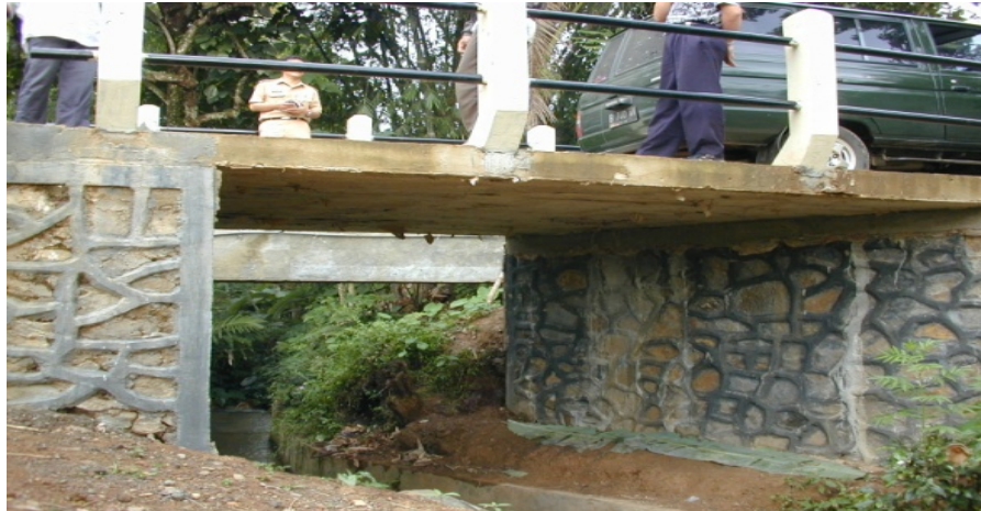
Jembatan Pelat Beton
