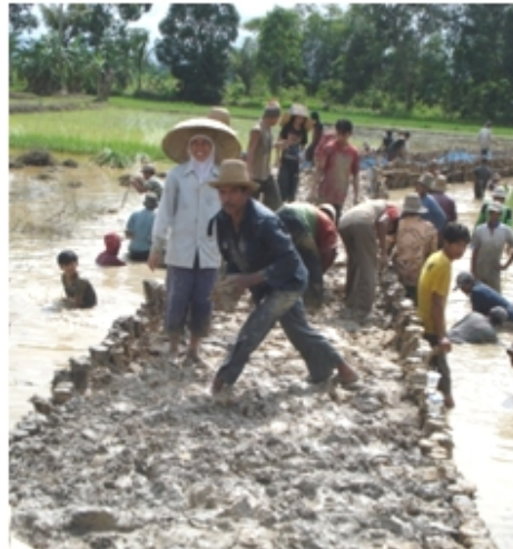
Pembuatan badan jalan di daerah dengan pancangan kayu
