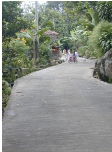
Jalan beton tanpa bahu
