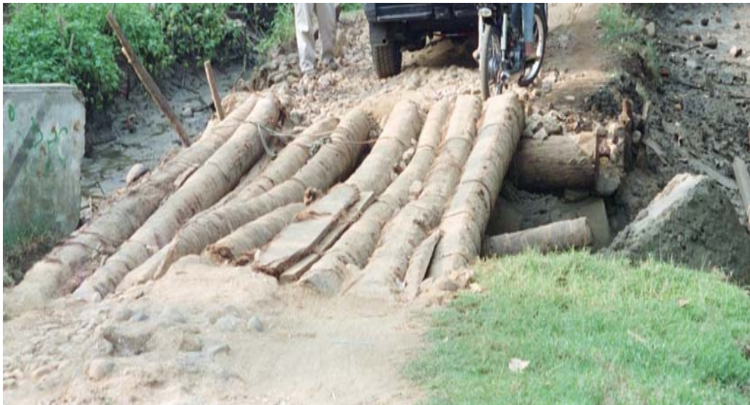
Jembatan Batang Kelapa
