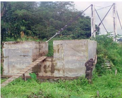
Jembatan gantung tanpa oprit
