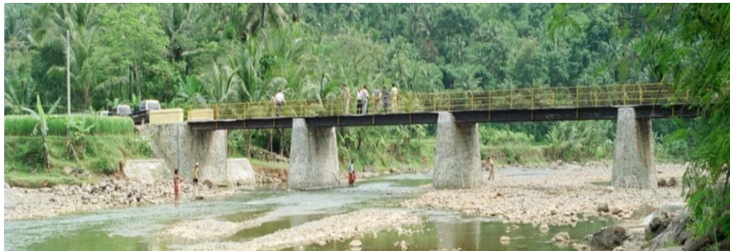
Jembatan Gelagar Baja
