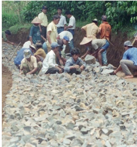
Kelompok menyusun batu kecil untuk mengunci batu utama di jalan telford
