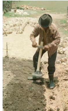
Pemadatan tanah secara manual di bahu jalan
