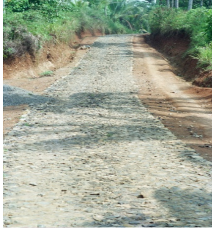
Jalan telford dengan bahu dan saluran
