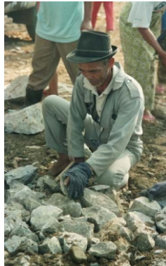
Penyusunan lapisan batu jalan telford
